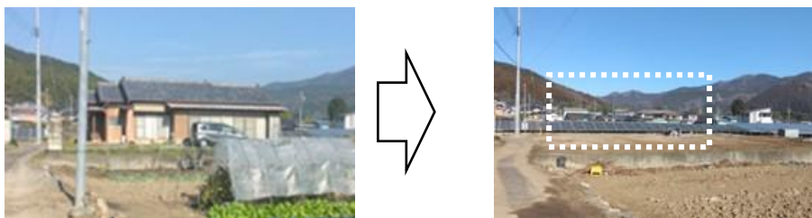
図4 数年放置された空き家を解体
