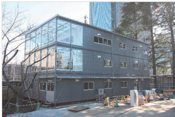
港区赤坂中学校等整備工事作業所
