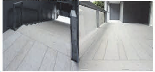
外階段、エントランス
