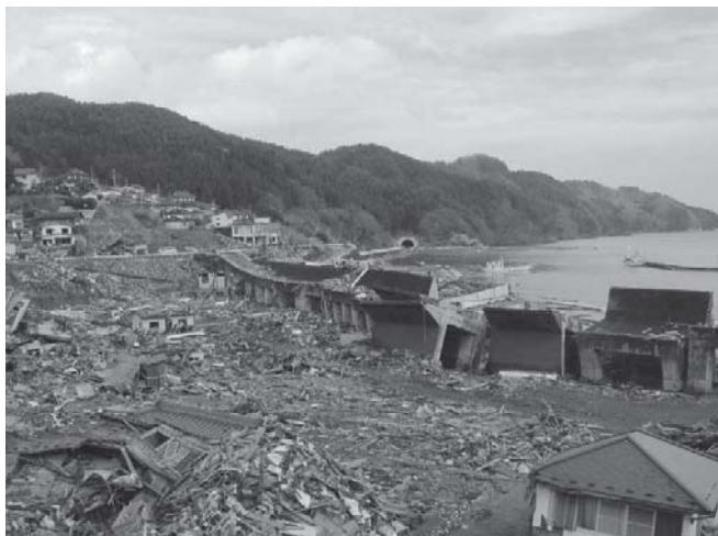
防波堤の転倒、家屋の破壊
